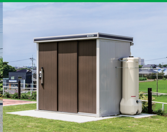
雨水タンクを付け「防災倉庫」に
